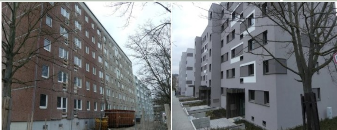
Рис. 6. Пример реконструкции дома в Германии: а) в процессе осуществления работ; б) после. (Источник: http://proekt.by/arhitektura_i_dizain-b26.0/kak_v_germanii_rekonstruiruyut_panelnie_doma-t53781.0.html .)
